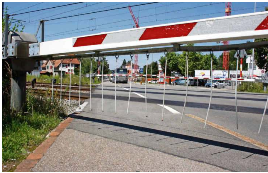
Nicht nur die Barriere, sondern auch die Planung der Unterführung Winterthurerstrasse ist «geschlossen».
